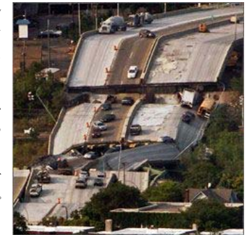
写真-1 崩壊した橋梁
