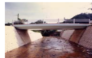
名護運天港線取付橋
